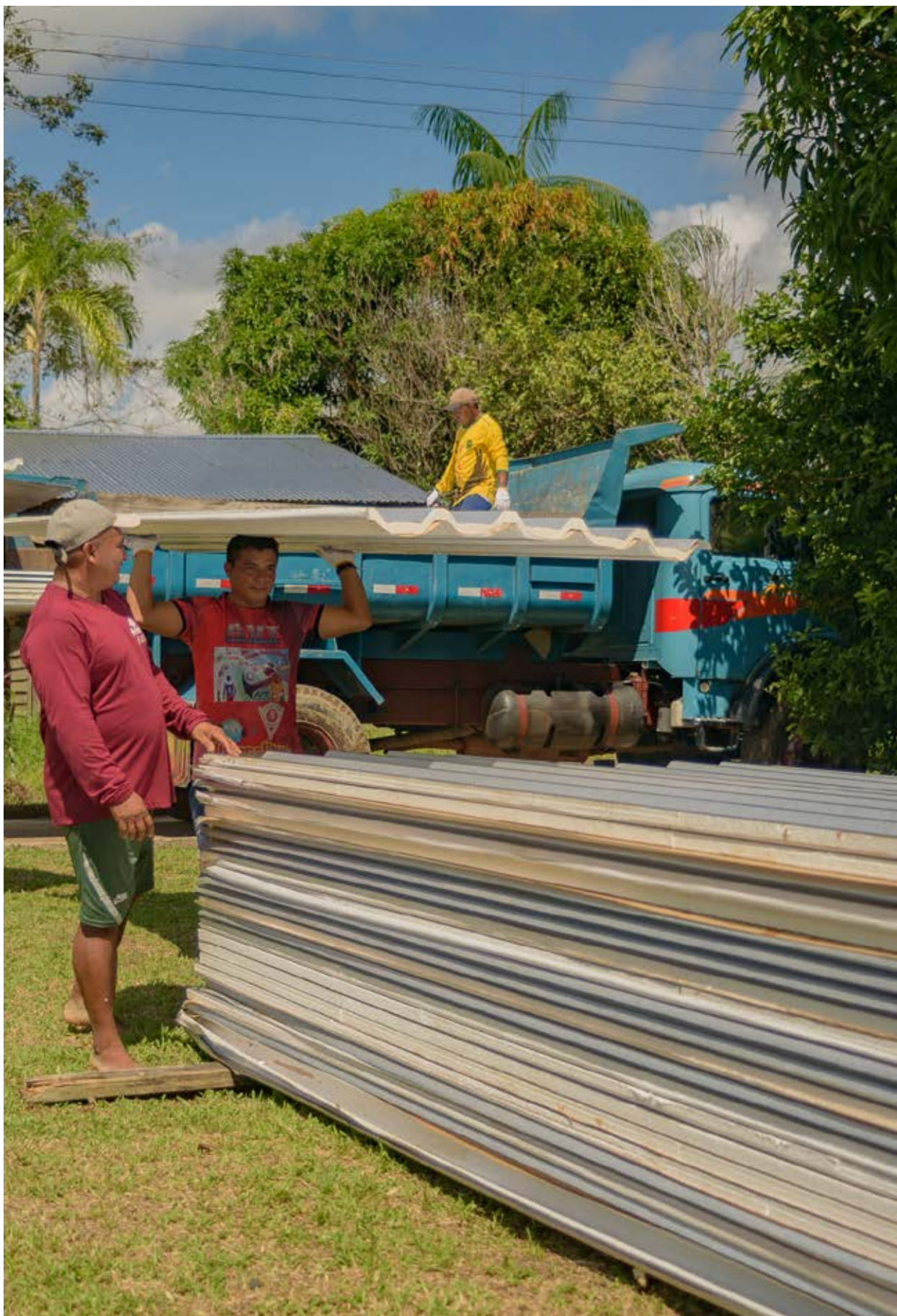
Transporte de material para obras de ampliação e reforma do NCS José Márcio Ayres, com apoio da Petrobras, na comunidade do Punã, RDS Mamirauá. Foto: Rodolfo Pongelupe
